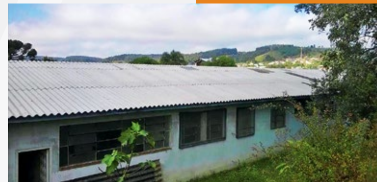
Hospital Santa Luzia, durante a reconstrução.
