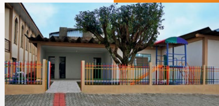
Creche Cantinho Feliz, após a reforma.
