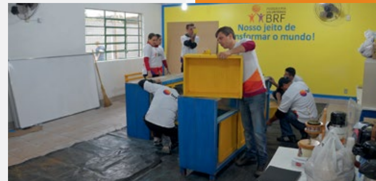
Creche Cantinho Feliz, durante a reconstrução.
